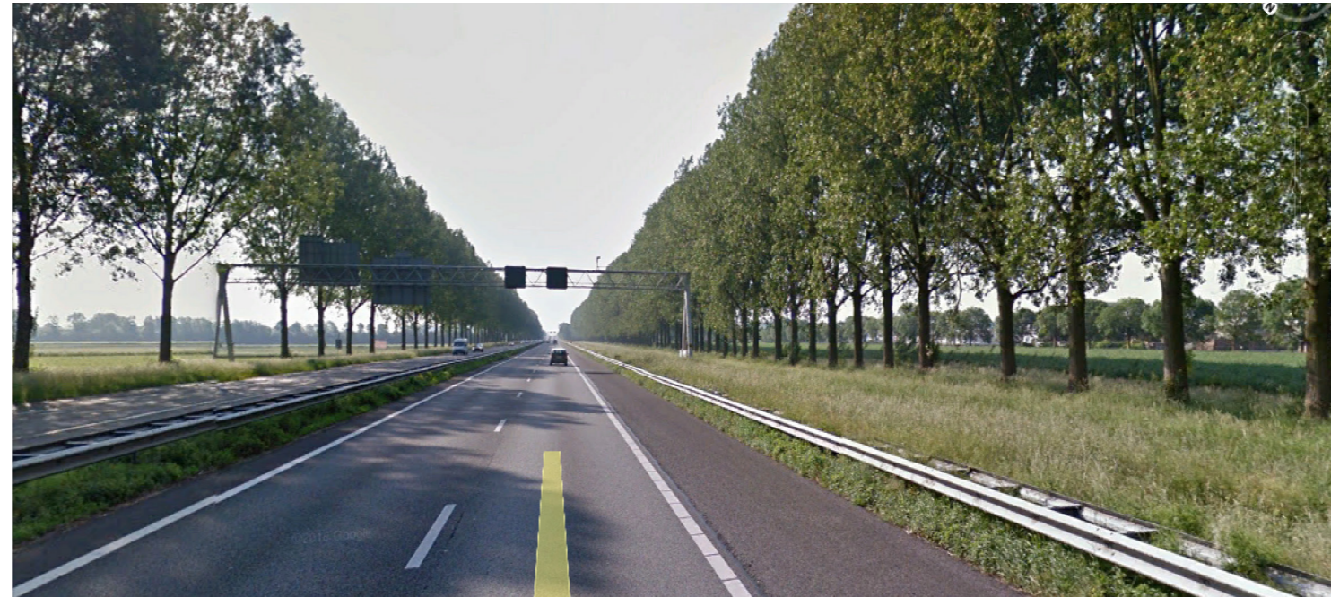
fotobeeld van de A12 ten noorden van Zevenaar met begeleidende beplanting en zicht op het omliggende landschap.
