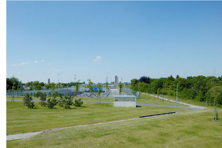
Voorbeeld van een groen ingerichte plaat over de snelweg als voorbeeld voor de 'deksel' bij Helhoek. Referentie: A16, bij Prinsenbeek (ontwerp: Juurlink+Geluk).
