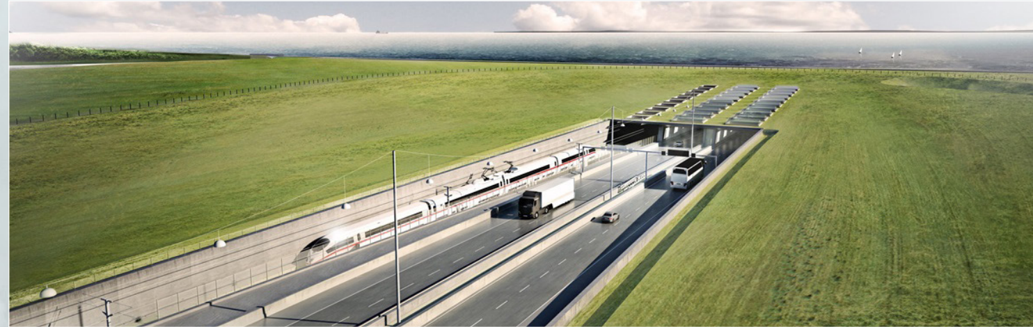
Referentiebeeld (half)verdiepte ligging: de Fehmarnbelt-tunnel tussen Denemarken en Duitsland. Met cruciaal detail met doorstekende wand en verdiept maaiveld. Dit wordt hier ook beoogd. Het is belangrijk dat er geen los hekje op de muur komt!
