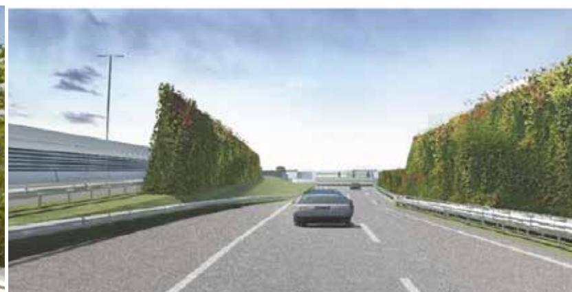
^ Illustratie architectonisch vormgegeven geluidwering in de middenberm met de dubbelzijdig begroeide geluidwering aan de buitenzijden
