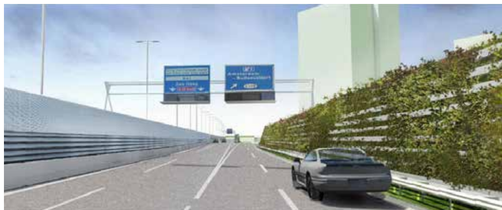
^ Illustratie architectonisch vormgegeven geluidwering in de middenberm en de dubbelzijdig begroeide geluidwering aan de buitenzijde, gezien vanaf de doorgaande baan en deparallelbaan (zicht vanaf parallelle rijbaan richting westen ter hoogte van Kop Zuidas)
